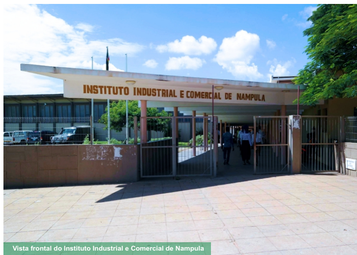
Vista frontal do Instituto Industrial e Comercial de Nampula
